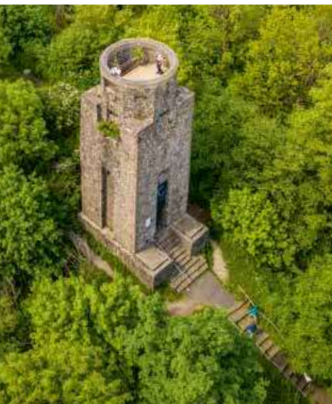
Kaiser-Wilhelm-Turm auf der Hohen Acht
